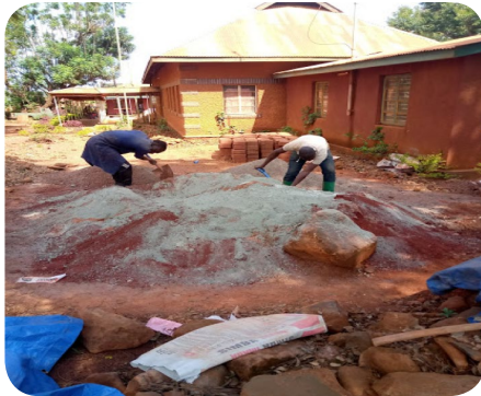
Mélange de terre et de ciment pour la fabrication de briques (à gauche), pose des murs (au centre) et construction d'un bâtiment d'enregistrement au camp de Nduta (à droite).
