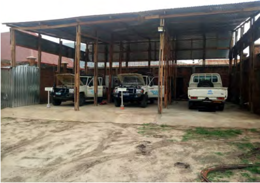
Nouveau garage et construction du bureau d'Uvira et du magasin de pièces détachées au Sud Kivu, RDC
